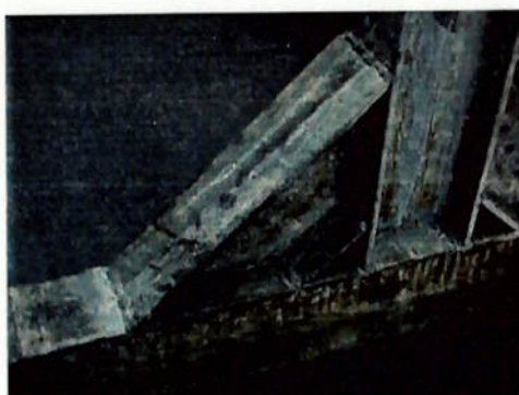
Fotografia dos reforços da haste vertical
