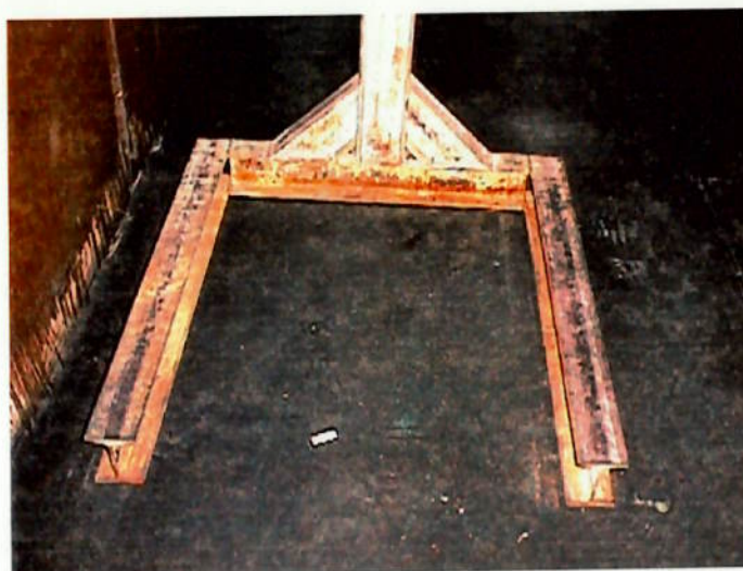
Fotografia da base em U e no detalhe o perfil em I das vigas
